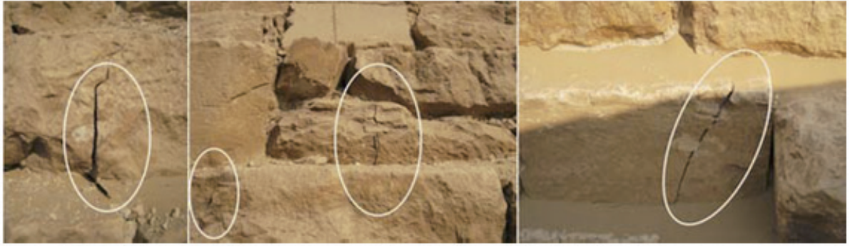
Fig.8 ウナスのピラミッドへの参道の南側擁壁の積石の亀裂
