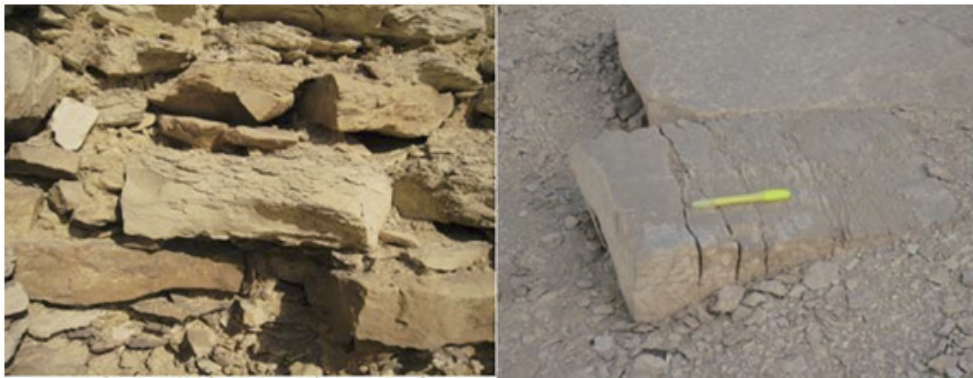
Fig.6 階段ピラミッドにみられる石灰岩の風化（左：ウロコ状風化 / 右：層理面剥離）
